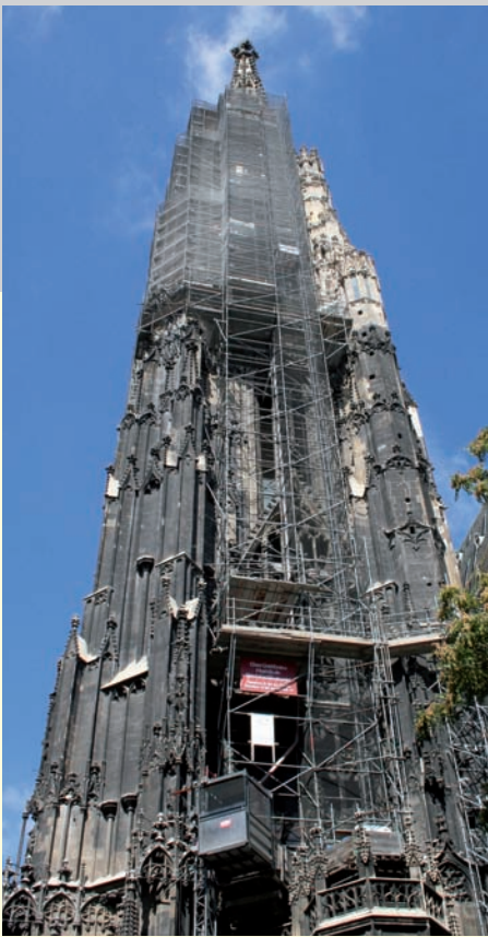
Der Südturm von St. Stephan wurde 1433 vollendet. Die Höhe von exakt 136,44m entspricht 444 Fuß.
